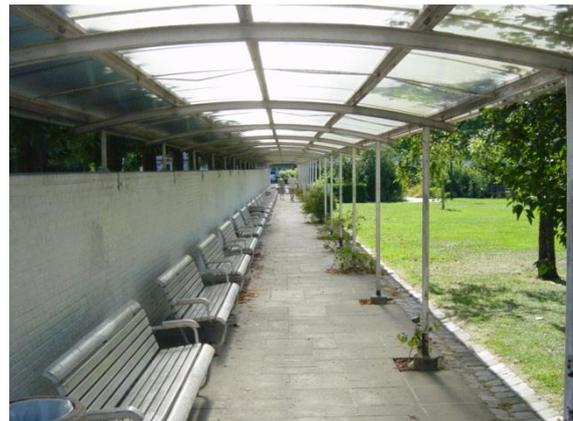
Des murs en briques blanchies adossaient jadis les bancs de ces petites chambres. Ils furent remplacés début des années septante par des murs en béton, les briques d'origines souffrant d'un défaut de fabrication.
