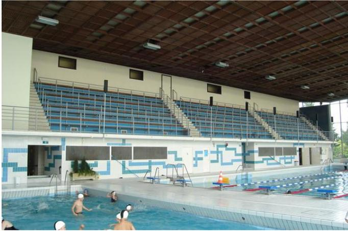
► Les **chantiers de rénovation les plus importants** ont été menés depuis 2007 : **remplacement de la verrière de la piscine, installation de nouveaux systèmes de ventilation et de chauffage et rénovation complète des gradins surplombant les bassins**. Les anciennes balustrades ont été remplacées par un modèle mieux profilé et rehaussé, répondant aux normes de sécurité en vigueur, tandis qu'ont été installées de toutes nouvelles assises en bois marin.
