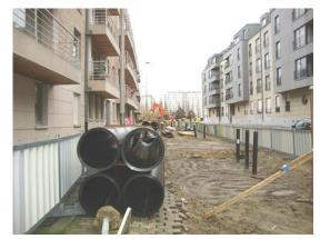
affecté par cet affaissement, la société Vivaqua a remplacé totalement ses installations. Le remblaiement a été effectué avec une terre plus stable qui évitera, tant que faire se peut, le tassement. Les conduits d'égouts sont dans un matériau spécifique plus souple qui permet de supporter d'éventuels petits mouvements du terrain.
