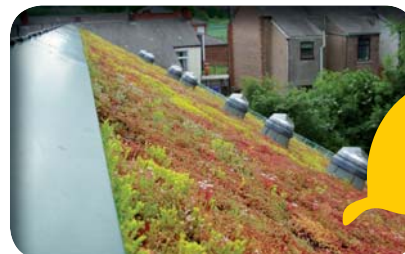
Exemple de toiture verte
