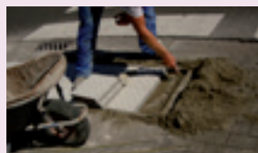
Aménagement de dalles podotactiles pour personnes mal voyantes
