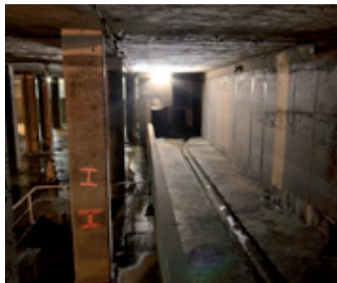
Le bassin d'orage chaussée de Roodebeek.
